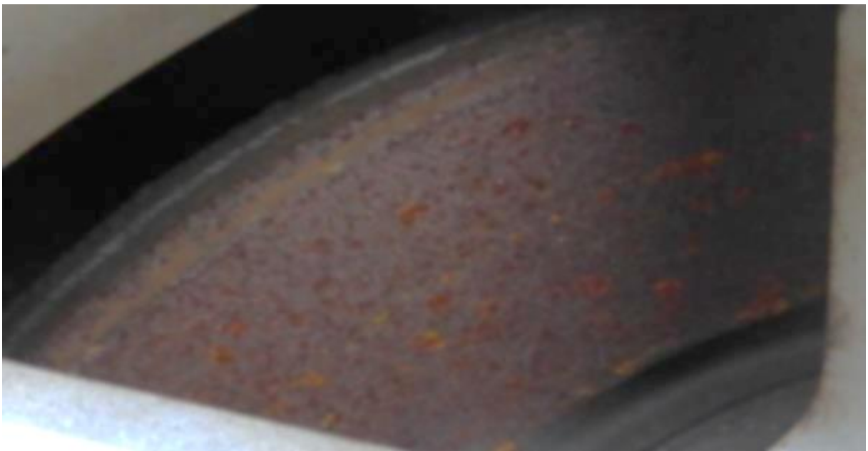
Značná koroze kotoučů brzd.
